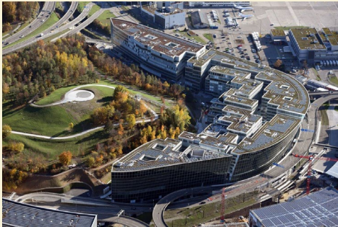
The Circle at Zurich Airport (2020) ©Flughafen Zürich AG
